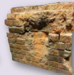
被炸的大阪炮兵工厂的砖墙
